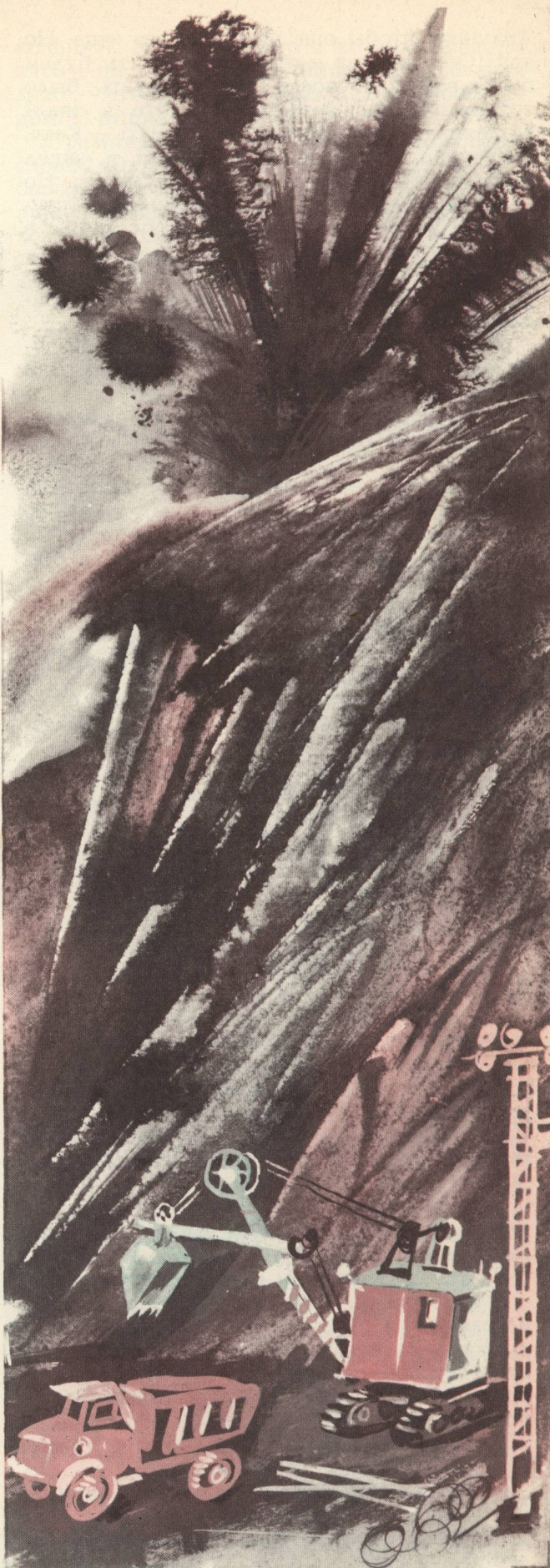
К площадке со всех сторон, как на штурм крепости, двинулись экскаваторы.
